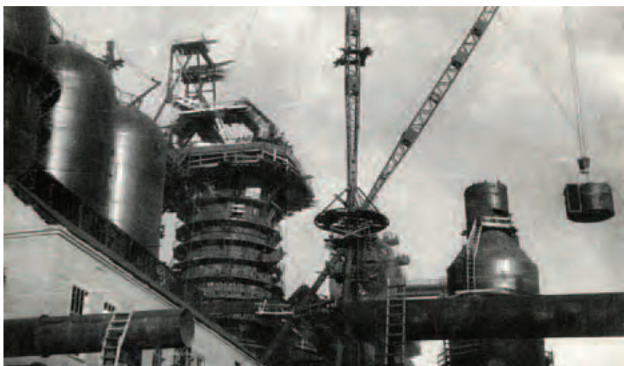
Строительство комплекса доменной печи №6 на Магнитогорском комбинате
